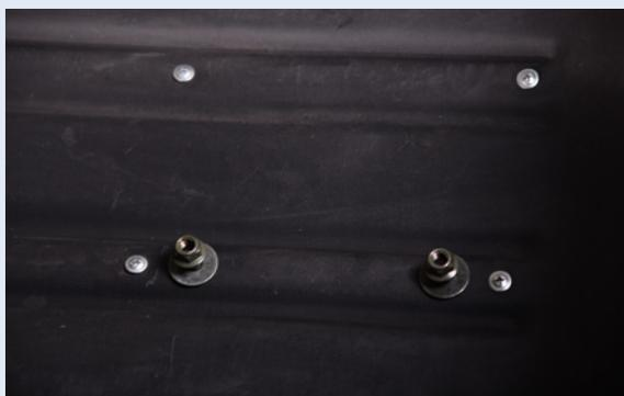
9 Затяните гайки крепления конька.
